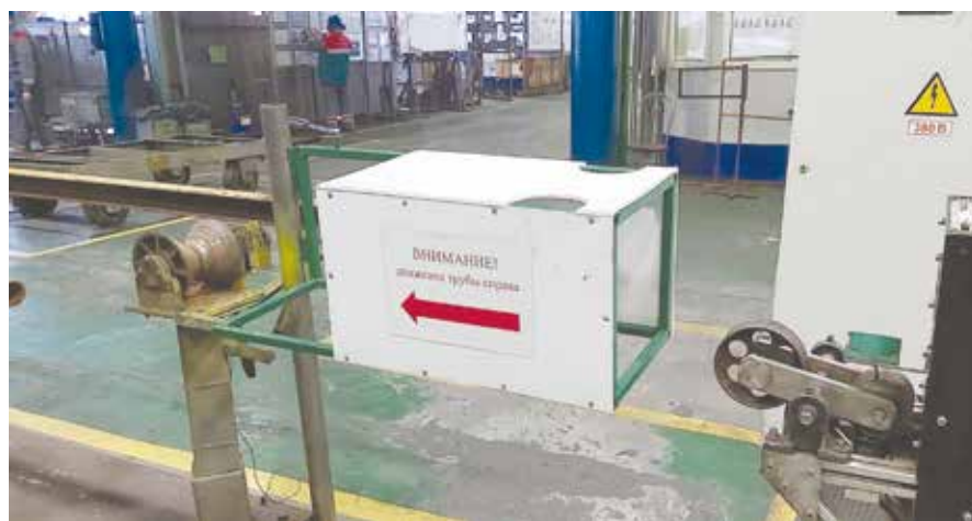
Идея старшего механика Евгения Иванова позволяет во время движения трубы исключить риск соприкосновения персонала с трубой с обеих сторон линии.
